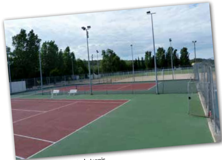
• Restauration des courts de tennis
