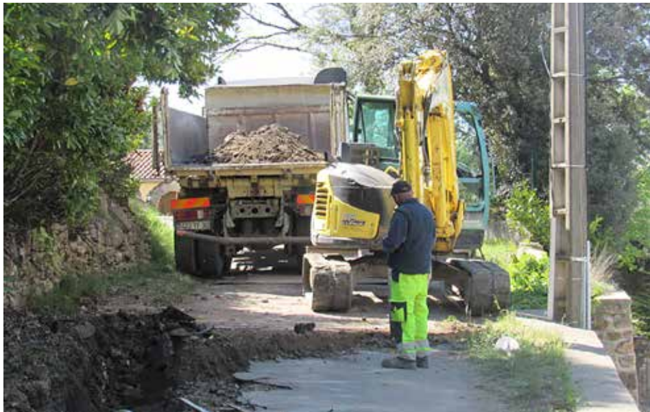
• Prolongement du réseau d'assainissement collectif à Arbousse
