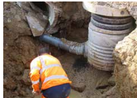
• Travaux sur les réseaux
