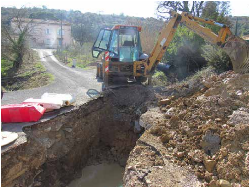
• Recalibrage du pluvial chemin de Granaudy
