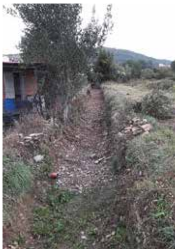
Courlas : curage du ruisseau
