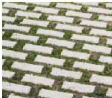
Pavage en béton avec ouvertures de drainage
