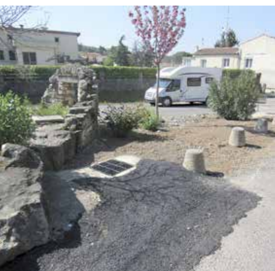
• Travaux sur le pluvial Route Vieille
