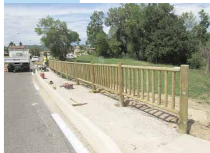
• Pose de barrières, avenue des Mimosas
