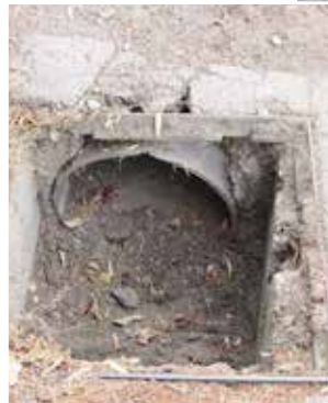
Désobstruction des buses pluviales
