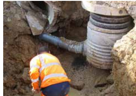
• Travaux sur les réseaux
