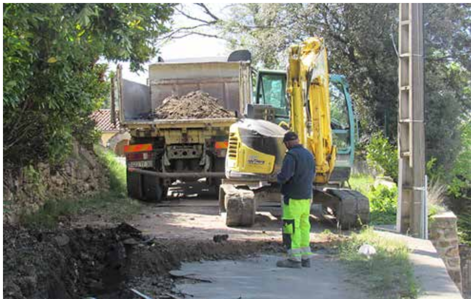
• Prolongement du réseau d'assainissement collectif à Arbousse
