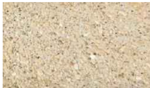
Photo 2 : illustration finition du revêtement de trottoirs
