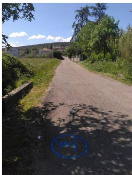
Photo du chantier
