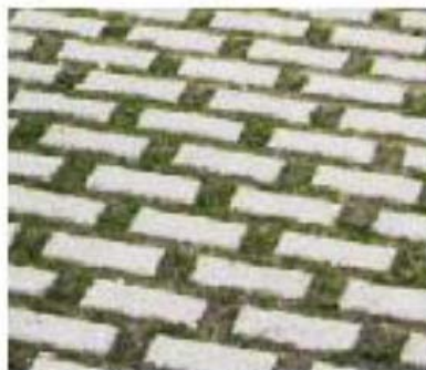
Pavage en béton avec ouvertures de drainage
