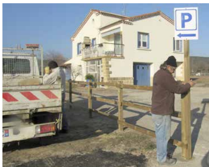
• Pose d'une rembarde séparative
