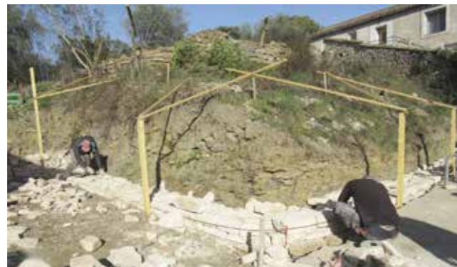
• Mur en pierre de la placette
