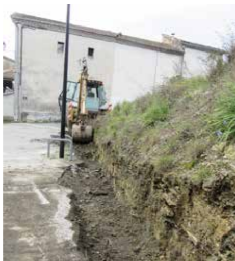
• Fondations pour pose du mur en pierres sèches
