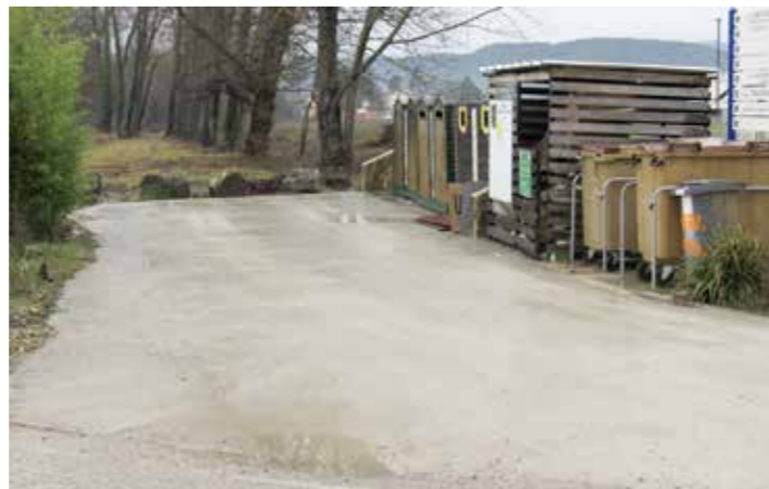
• Béton de propreté PAV du Grès
