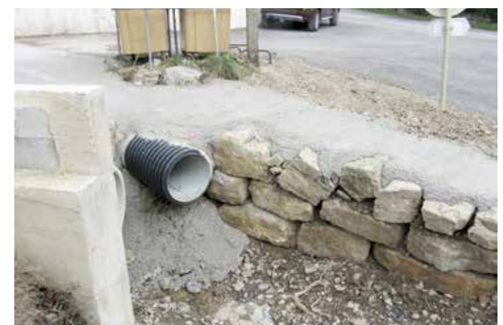
• Consolidation des berges, Les Issards
