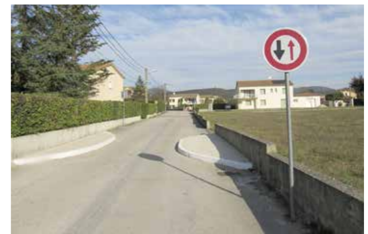
• Mise en place de chicanes, chemin des Grès
