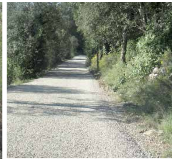
• Réfection chaussée chemin Mathieux
