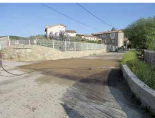
• Aménagement pluvial + ralentisseur Hauts de Courlas
