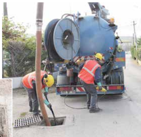
Désobstruction des buses pluviales
