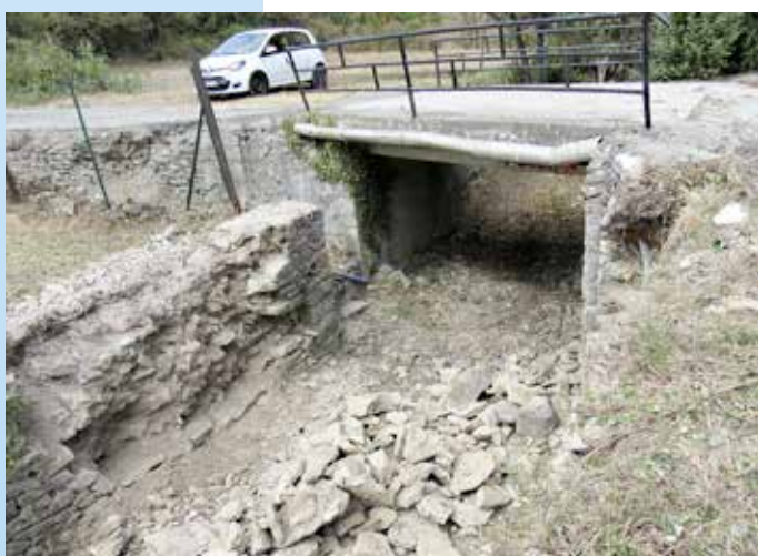
Réfection des murs : ruisseau de Caussonille
