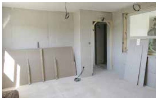
Agrandissement mairie : intérieur/extérieur
