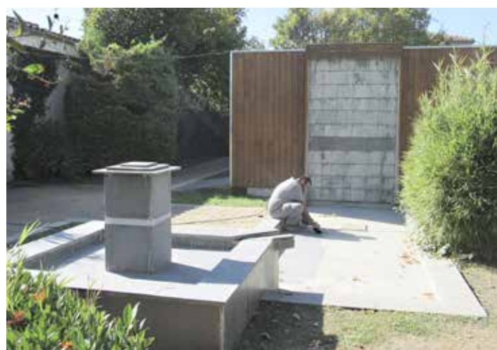
Décapage du bassin près de l'école
