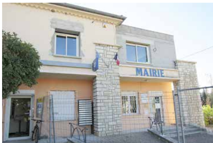
Ouverture d'une fenêtre supplémentaire façade ouest
