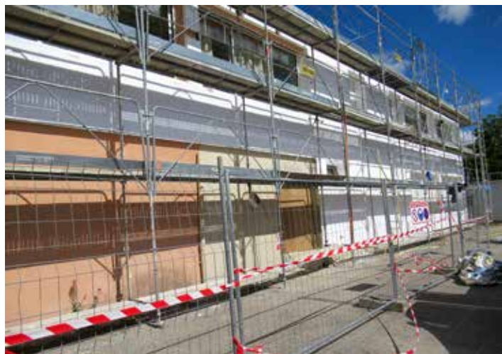
Isolation par l'extérieur, côté Est
