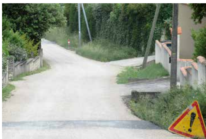
Réfection chaussée du Mas Vidal avec pose de ralentisseurs
