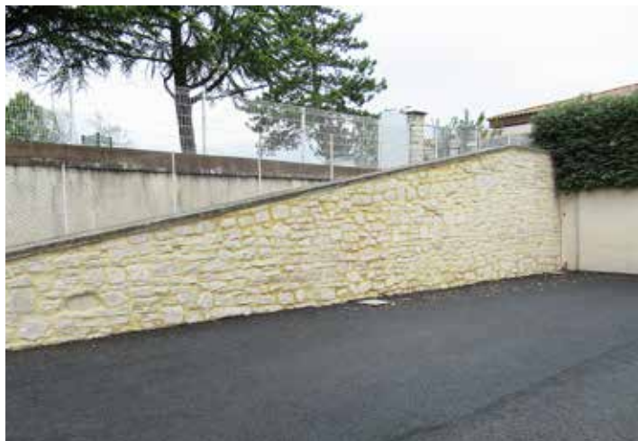
Reprise du mur soutenant le chemin d'accès
