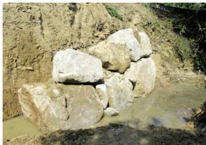
• Les différentes étapes de l'enrochement derrière la salle Biscarat.
